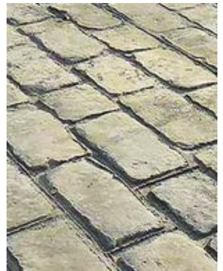
CEMENTO STAMPATO Esterni pedonali
