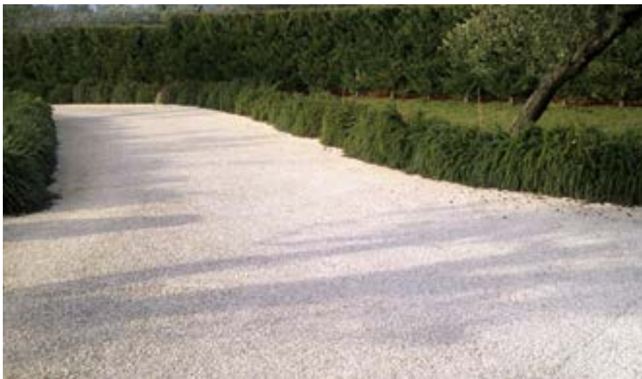
PAVIMENTAZIONE ESTERNA Carrabile e drenante
